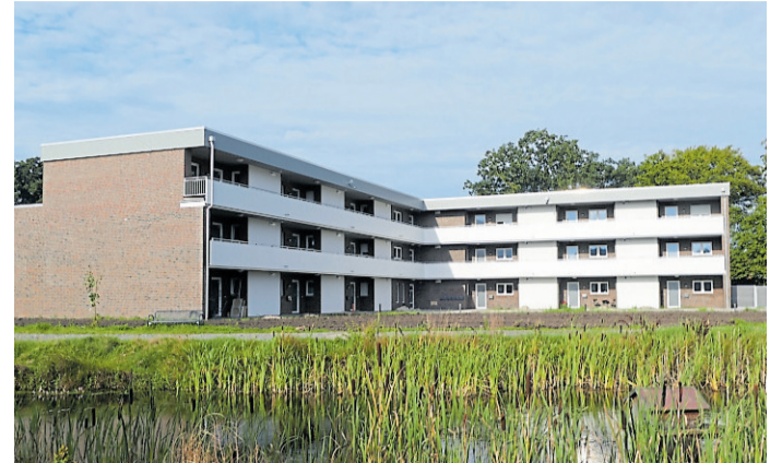
Das neue Apartmenthaus im Meynens Moor 2 ist idyllisch an einer Teichanlage gelegen. Die weitere Begrünung am Haus ist bereits angelegt.
