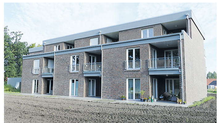
Die oberen Wohnungen verfügen über eine Loggia mit Gründach, die unteren zwölf Wohnungen jeweils über eine Terrasse.
